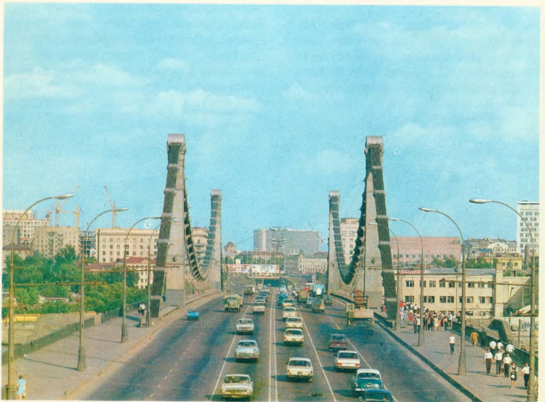
Крымский мост в Москве
