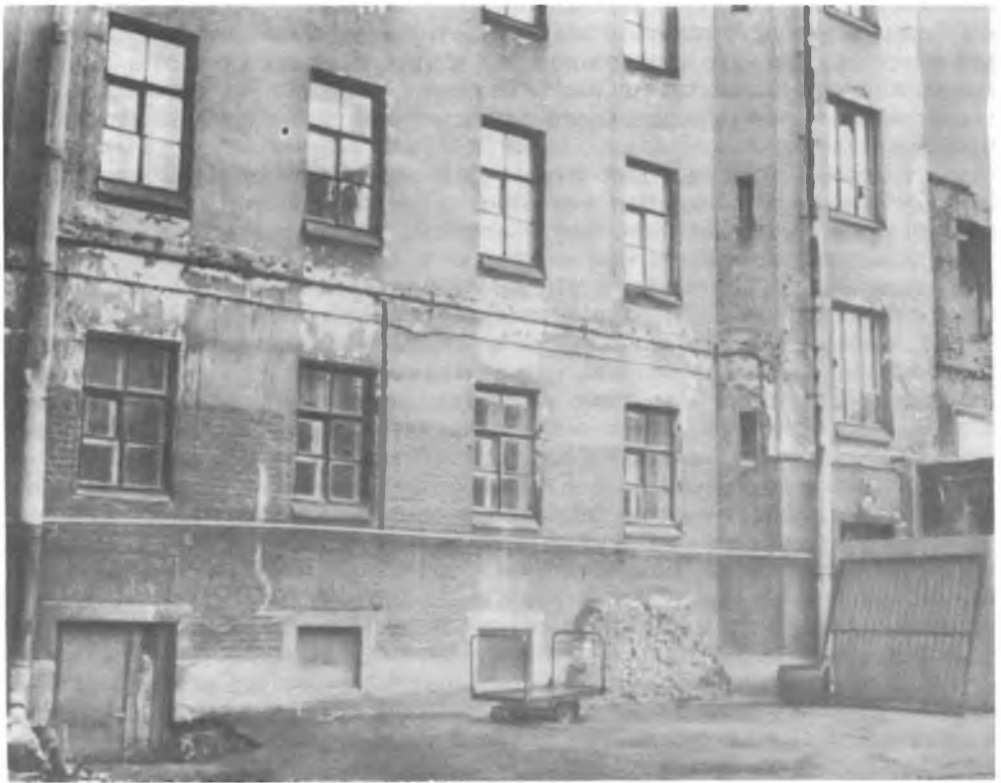
На втором этаже окна квартиры, в которой жил Юра
