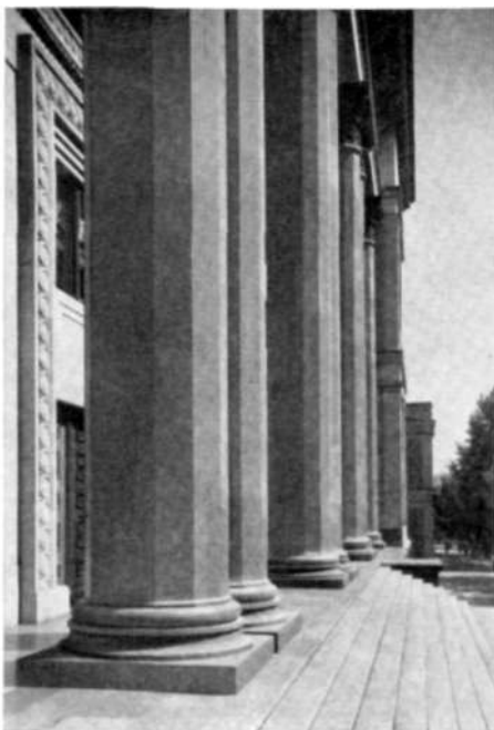
КОЛОННЫ ПОРТИКА ГЛАВНОГО ФАСАДА
