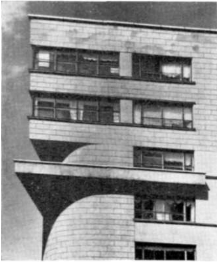
ЗДАНИЕ КООПИНСОЮЗА В МОСКВЕ. ФРАГМЕНТ.
