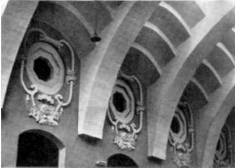
КАЗАНСКИЙ ВОКЗАЛ. ФРАГМЕНТ ПЕРЕКРЫТИЯ ТЕПЛОГО ПЕРРОНА
