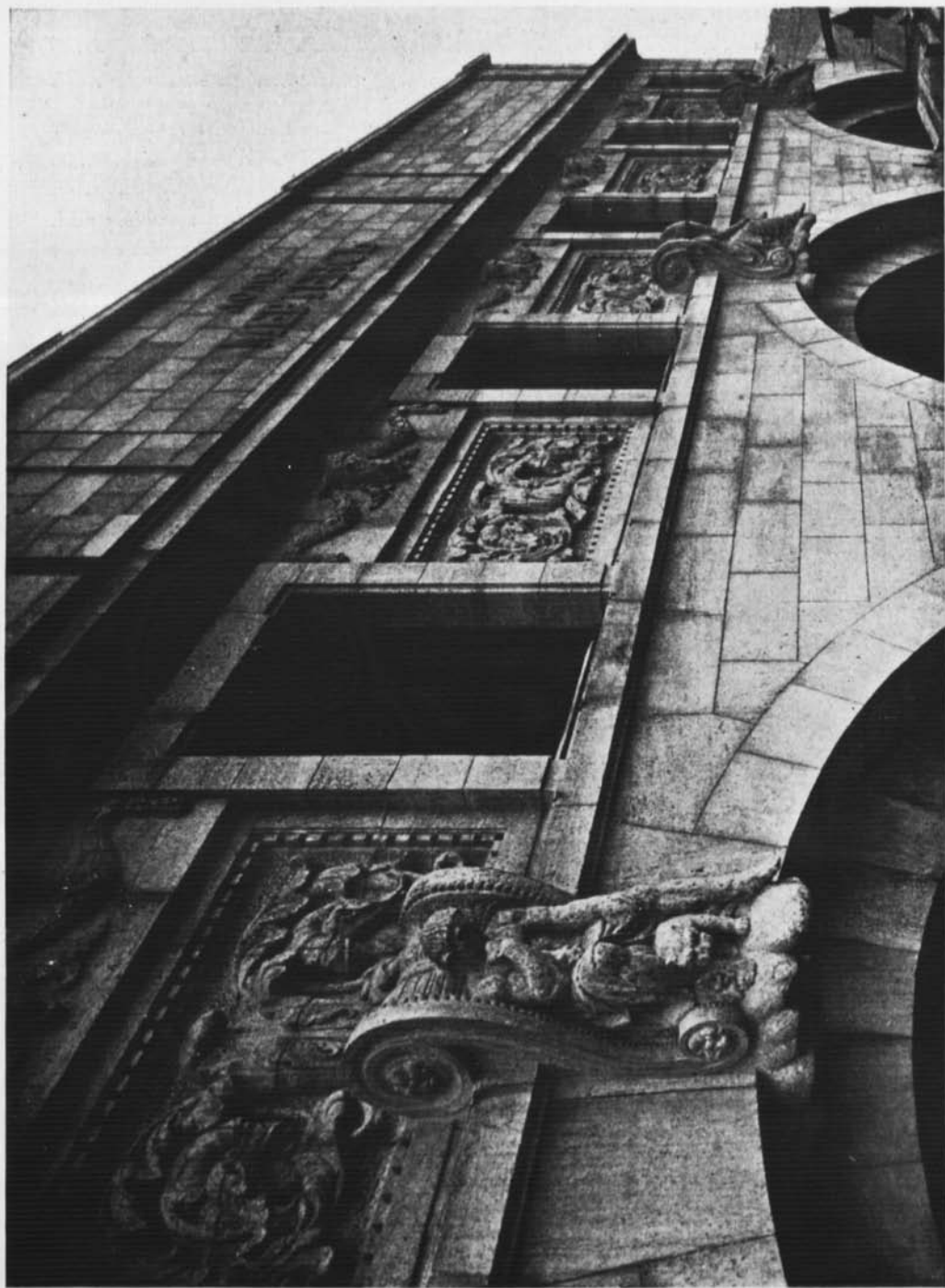
M. Lindewitsch. Détail de l'étage supérieur de la maison Merritts (Newsby, St. Pbg).
