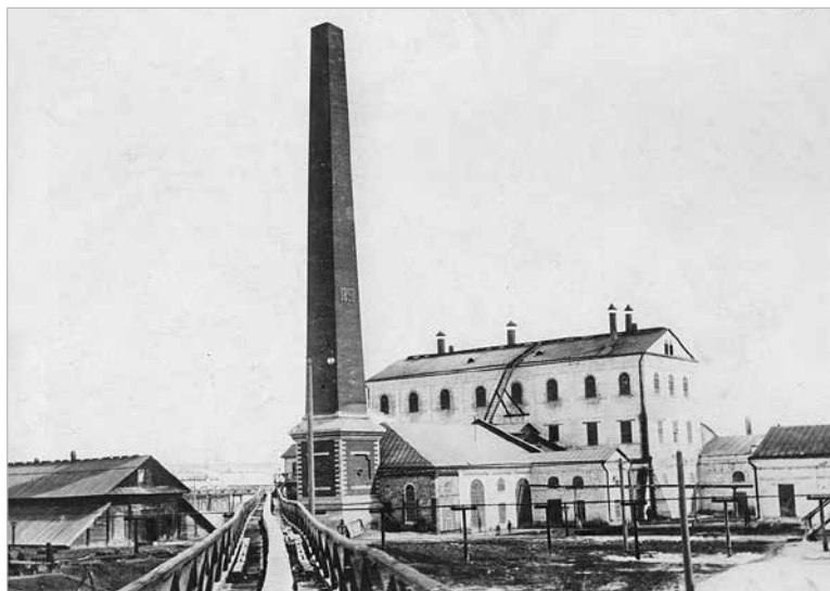
Бондюжский химический завод. Здание для регенерации марганца по способу Вельдона и электрическая станция для освещения заводов
