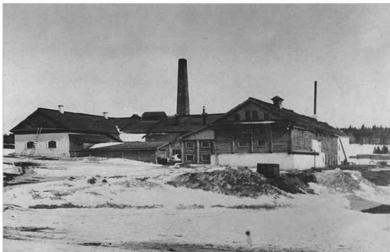
Кокшанский химический завод. Завод гончарных изделий и химических аппаратов
