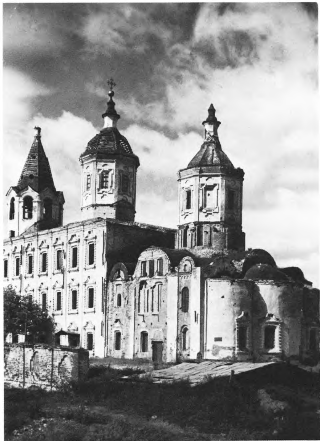
Смоленск. Церковь Петра и Павла (XII в.) начало реставрационных работ
