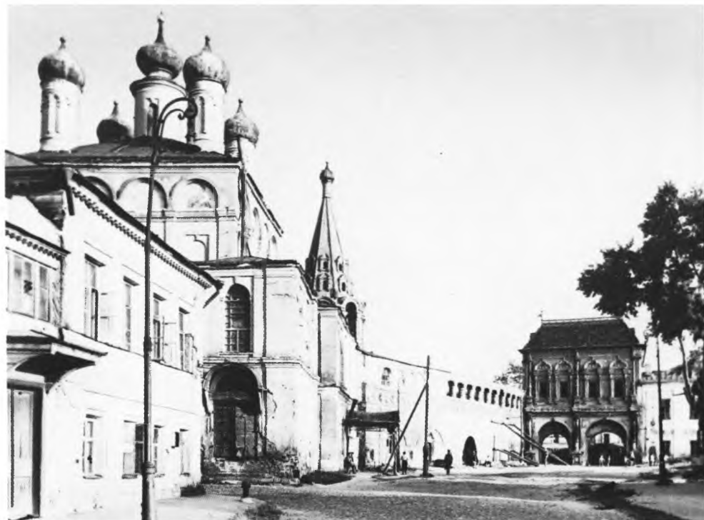
Москва. Крутицкое подворье до реставрации
