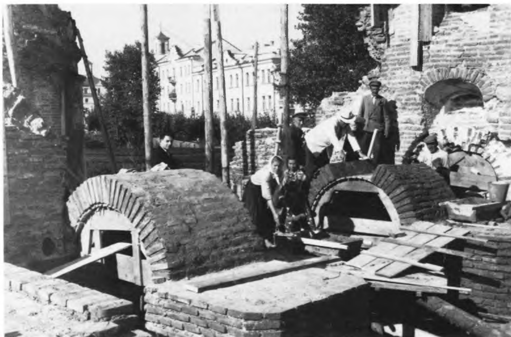
Реставрационные работы на церкви Параскевы Пятницы
