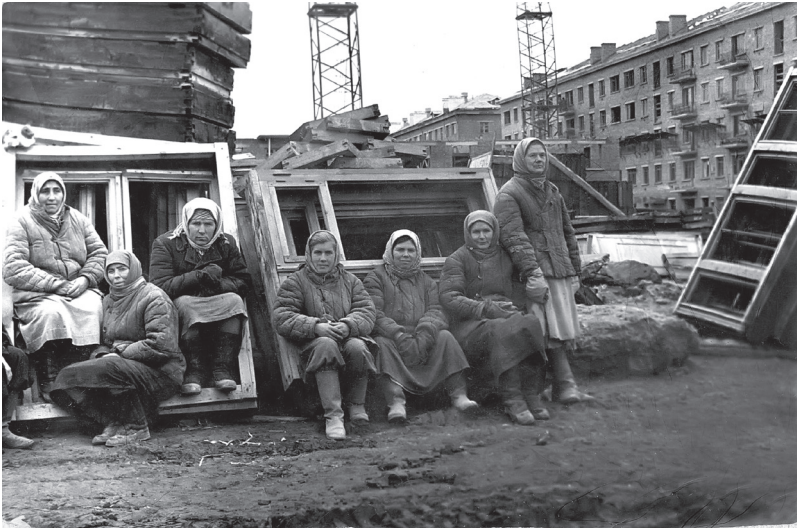
Бригада разнорабочих на строительстве Новосибирского Электротехнического института. Стоит справа бригадир М. Г. Бергман. Примерно 1953 г.
