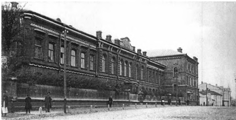
Здание Калужского епархиального училища
