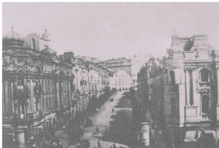
Киев, Николаевская улица. Слева — здание, где помещался клуб ХЛАМ (общества «Художники, литераторы, артисты, музыканты»)
