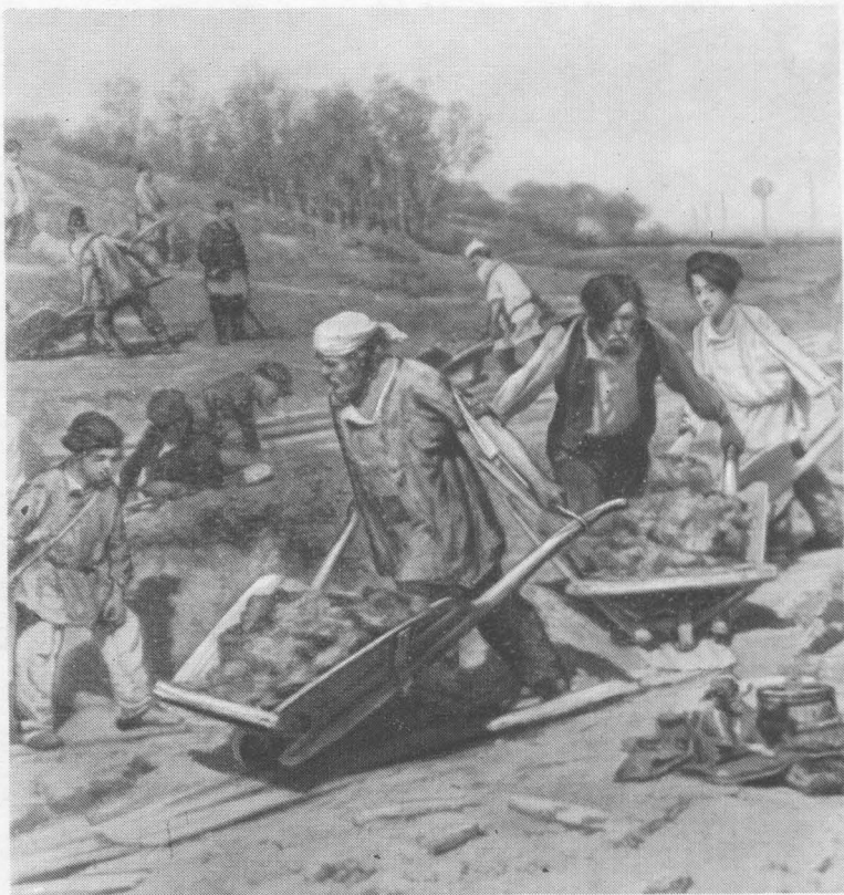
«Ремонтные работы на железной дороге» — с картины К. Савицкого.
