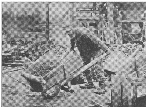
На стройке Уральского вагоностроительного завода
