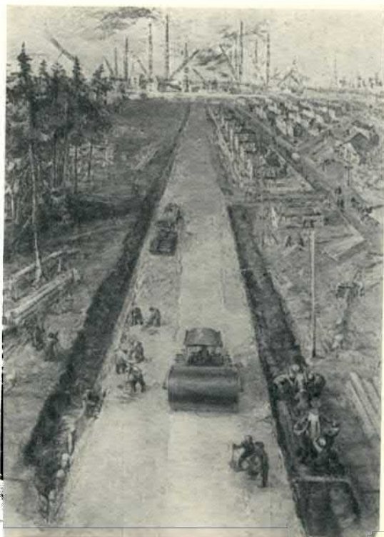
91. Б. Яковлев Дорога на строительство 1932
