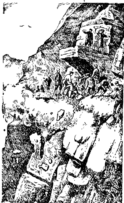
Сооружение дороги на Кавказе.
