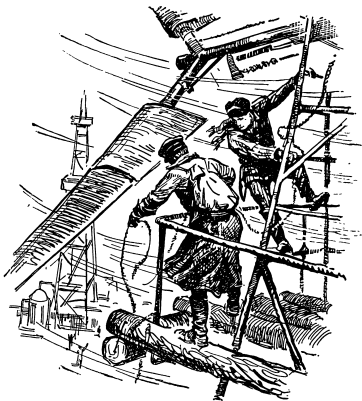
Сборка ветряка на нефтяной вышке в Баку.
