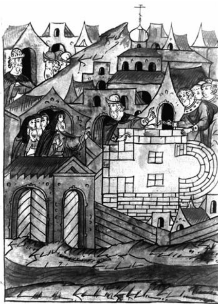
Сооружение фундамента церкви. Миниатюра Лицевого свода XVI в.
