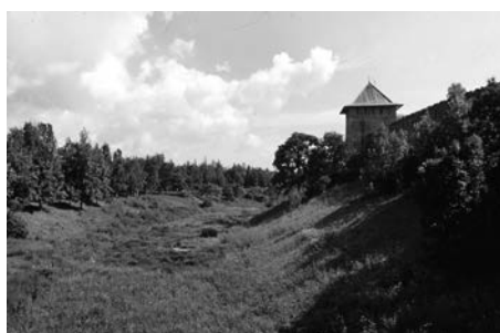
Новгород. Детинец. Стены, башня и остатки оборонительного рва
