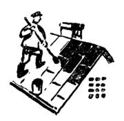
Верный способ спасти железо от ржавчины — это покрыть его слоем другого вещества, которое не пропускает сырости. Можно было бы покрыть железо каким-нибудь жидким маслом, например подсолнечным. Масло защитило бы железо от воды и не дало бы ему заржаветь.
