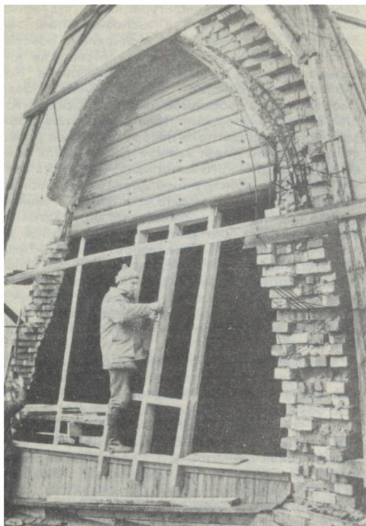
На строительстве музея. Монтаж конструкции световода. Мастер А. Вересов. Фото Ю. Щенникова. 1989
