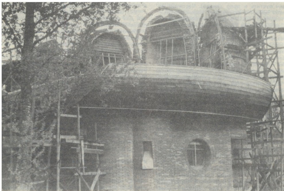
На строительстве музея. Монтаж конструкции световода. Мастер А. Вересов. Фото Ю. Щенникова. 1989
