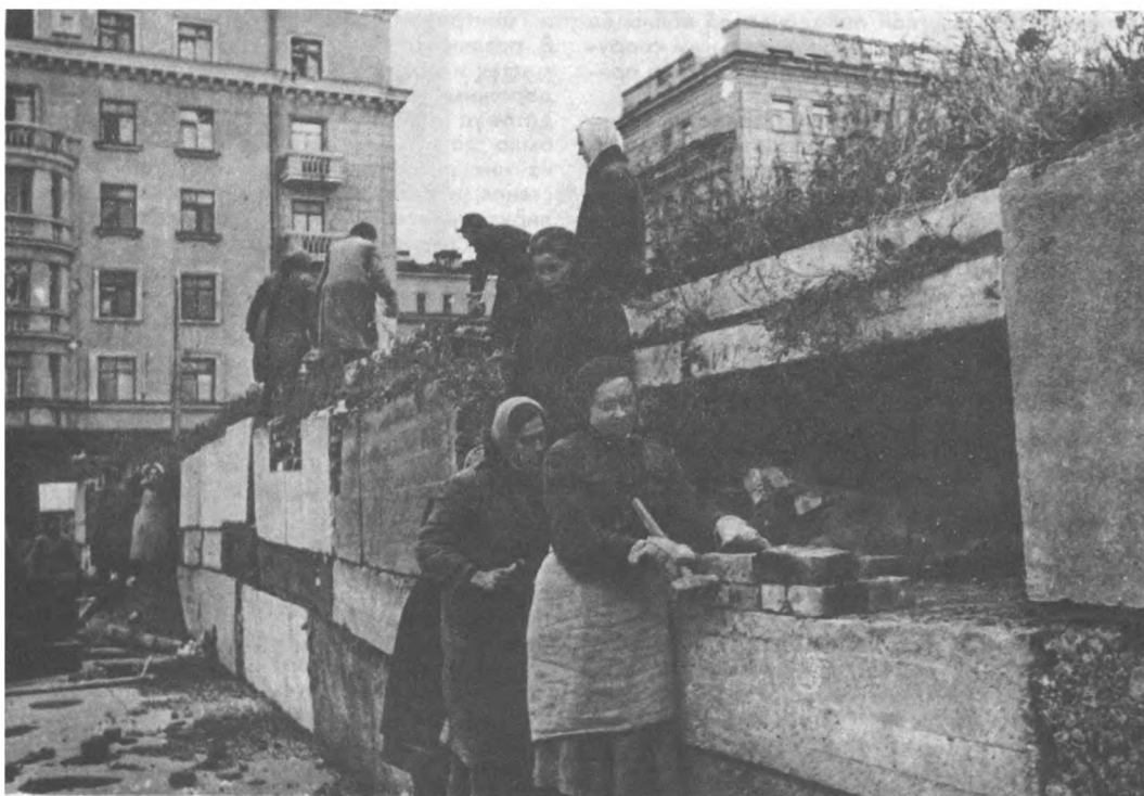
Строительство оборонительных сооружений в Московском районе. 1941. Фото Д. Трахтенберга
