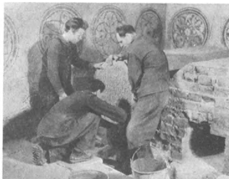
Установка плит надгробия после окончания реставрации.
