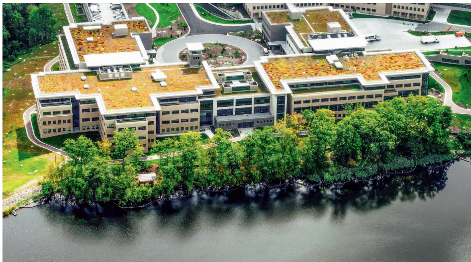
Комплекс главного управления Свидетелей Иеговы в штате Нью-Йорк (США) удостоился наивысшей оценки за экодизайн
