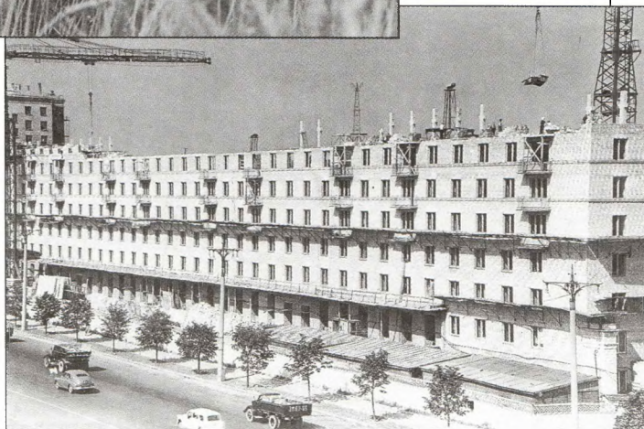
Строительство типового жилого дома в Москве.
