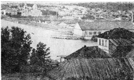
Заводская плотина. Очер.
