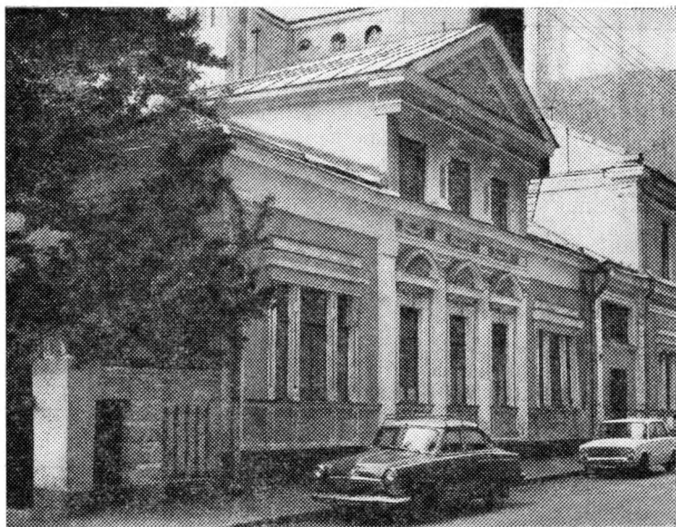
Дом И. С. Остроухова в Трубниковском переулке
