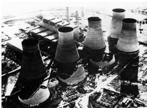
Разрушение градирен в Феррибридже (Великобритания, 1965)
