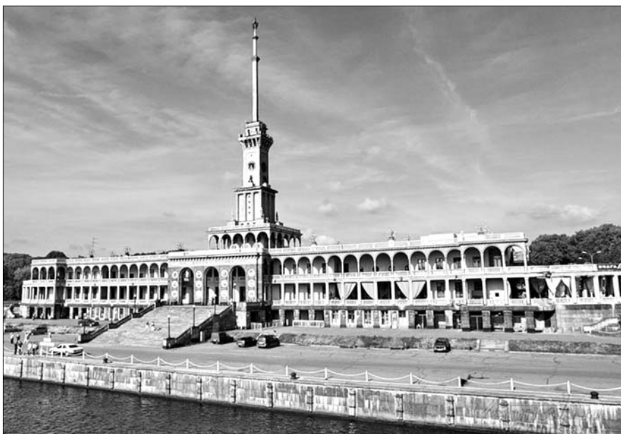
Здание речного вокзала на канале Москва–Волга. 1937 г.
