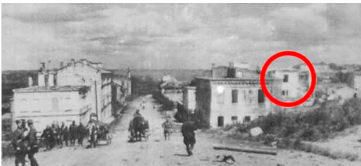
Фото улицы Калинина. 1944-20 г. Справа видна разрушенная Воскресенская церковь с наполовину разрушенной апсидой
