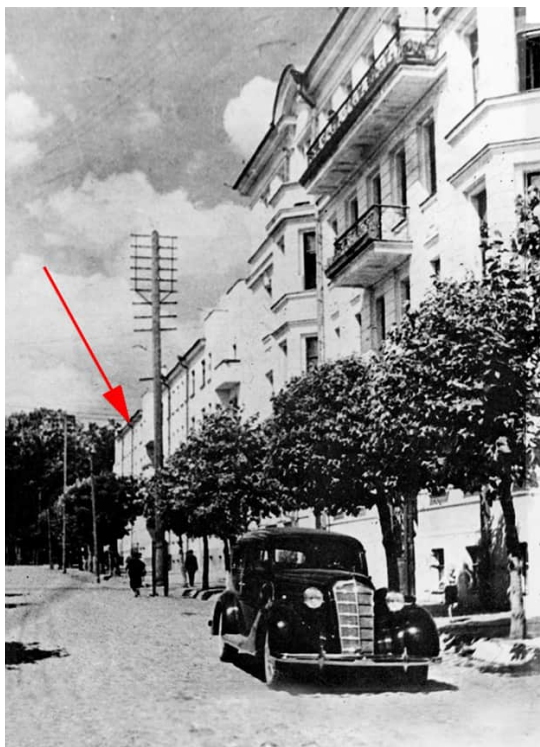
Первый коммунальный дом справа (нынешний отель «Эридан») и за ним, на противоположном углу – четвертый коммунальный с фасадом на улицу Советская. 1950-е годы. Вдали – парк 1812 года на Успенке.
