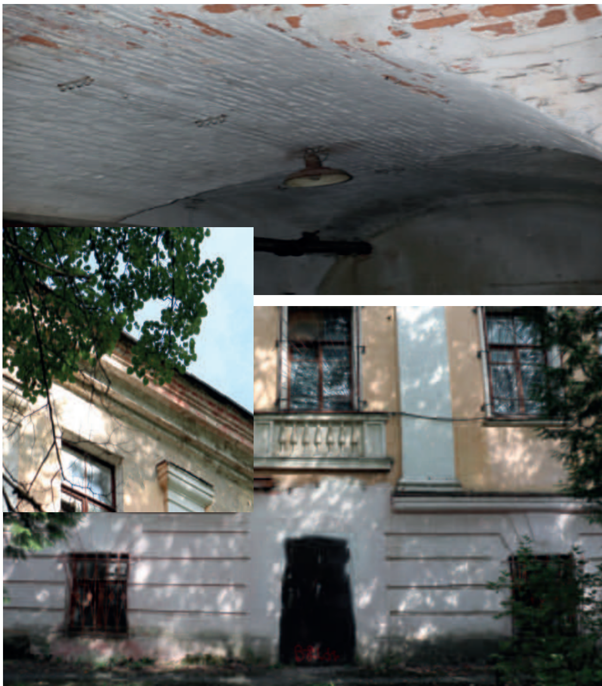
Своды первого этажа центрального здания. Их датировка – не позднее середины 19 века. Карниз центрального здания. Центр здания. Фото Г. Орловского
