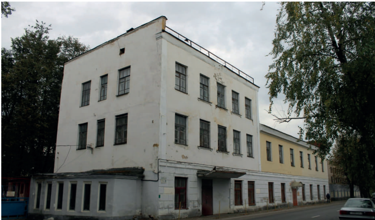
Правое здание. Фото Ю. Шепелева
