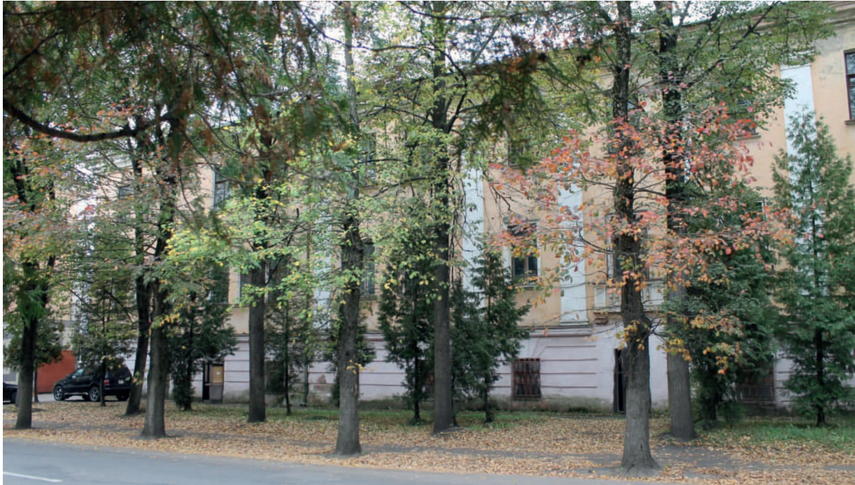
Центральное здание на быв. Канатной улице – быв. мастерская. Фото Ю. Шепелева
