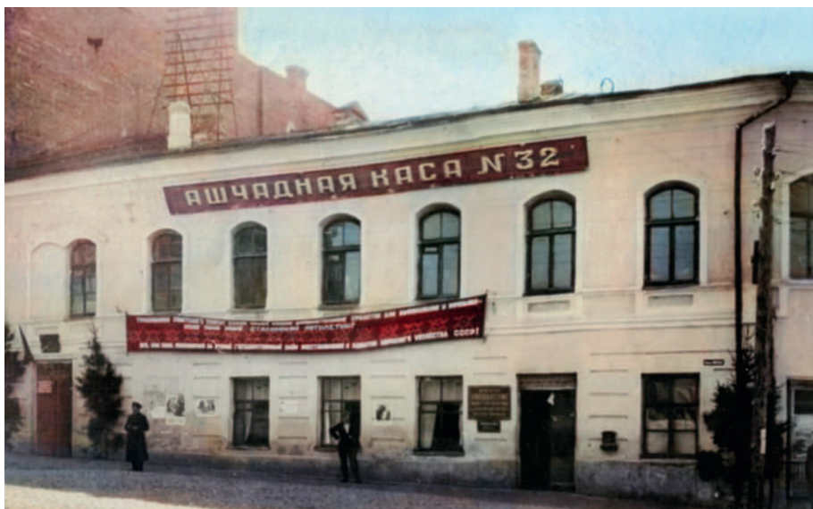
Площадь Свободы. Угловой дом. 1930-е гг. Балкон на углу во втором этаже отсутствует
