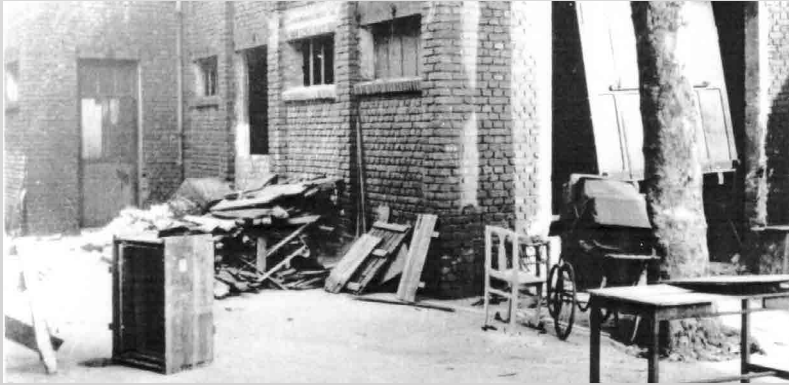
Rue de Lourmel, la future église en chantier
