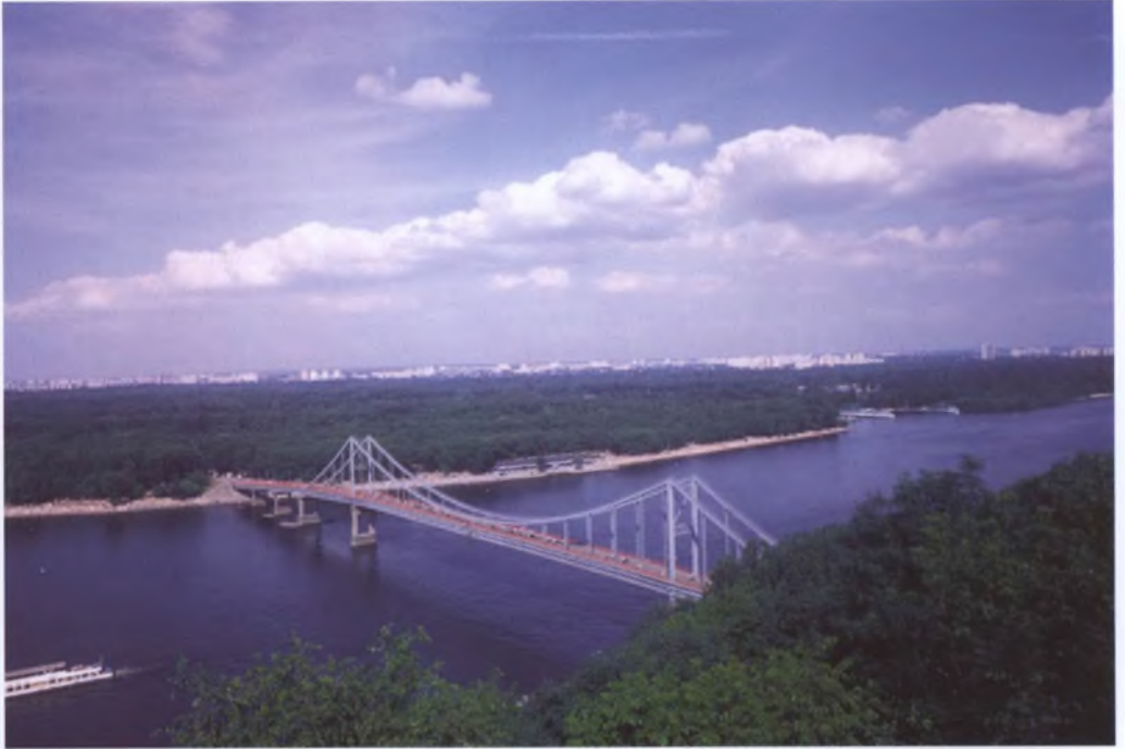
Пешеходный мост через Днепр.
