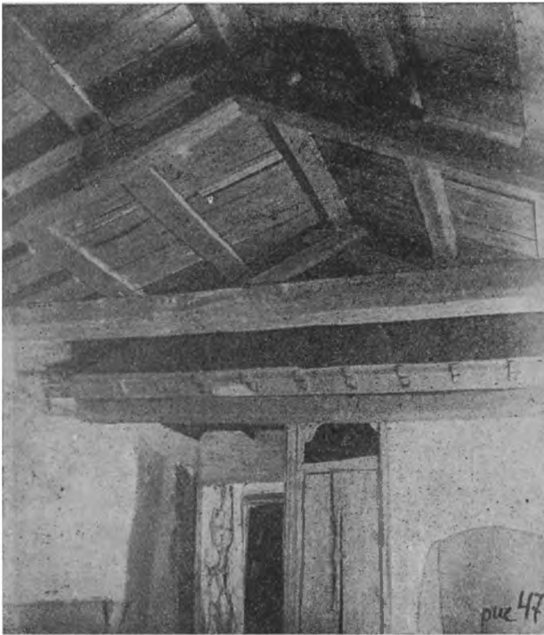
Бахчисарай. Конструкция крыши-потолка в старинном доме. Baktchi-Saraï, Construction du toit-plafond dans une maison ancienne.
