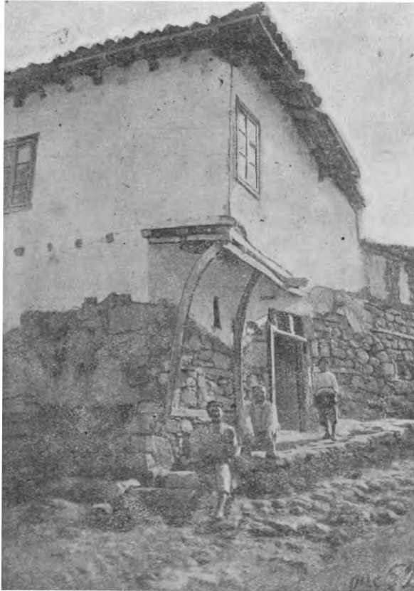
Бахчисарай. Дом с выступающим вторым этажем на консолях. Baktchi-Saraï. Maison avec l'étage saillant à des consoles.
