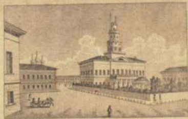
Вид с Триумфальной Колонны на Соборную Палату
