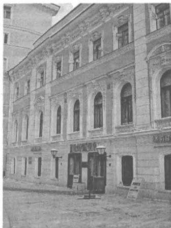
Дом печати (ныне — Центральный дом журналиста). Современный вид
