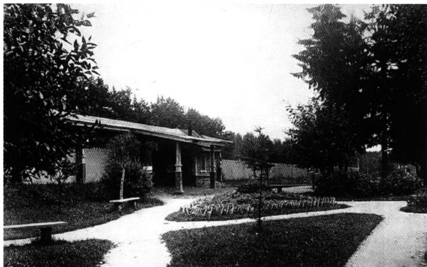
Малаховка. Сквер перед входом на станцию
