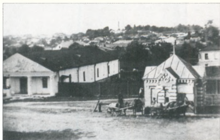
Водоразборная колонка ("водокачка") на Манежной площади, теперь улица Степана Разина
