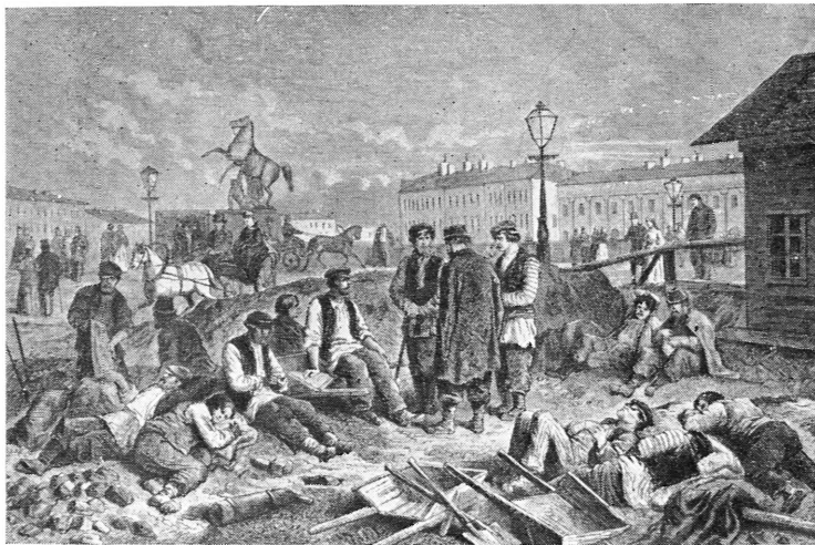
Ремонтные работы на набережной Фонтанки. Литография. Середина XIX в.
