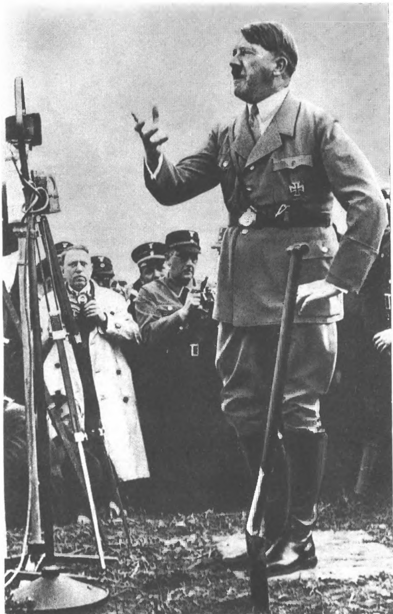
На открытии строительства имперского автобана
