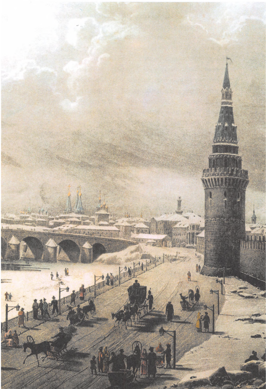
Каменный мост. 1825 год. Фрагмент
