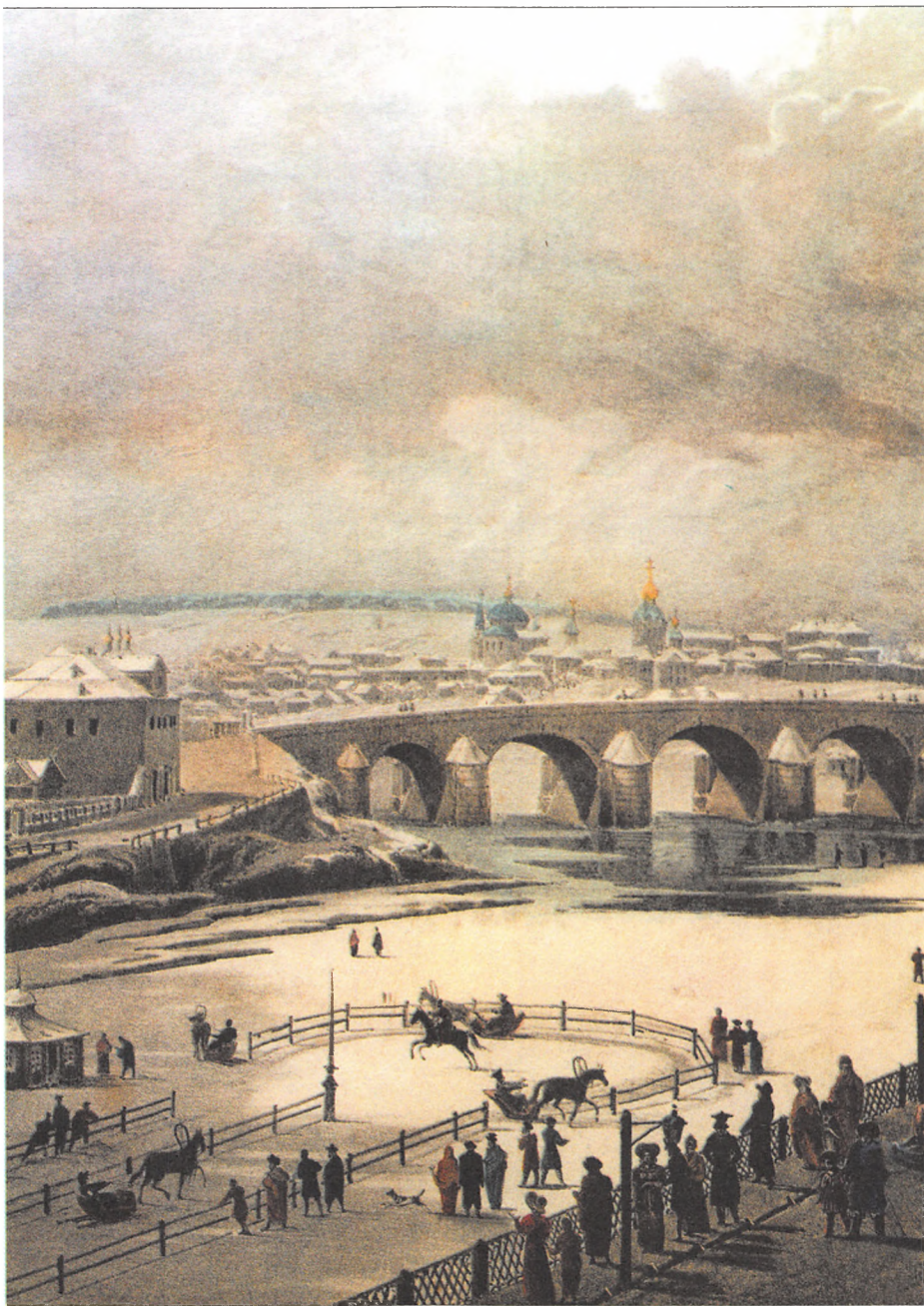
Каменный мост. 1825 год. Фрагмент
