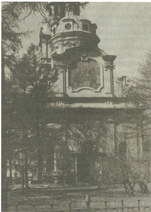
Петропавловский собор. Восточный фасад
