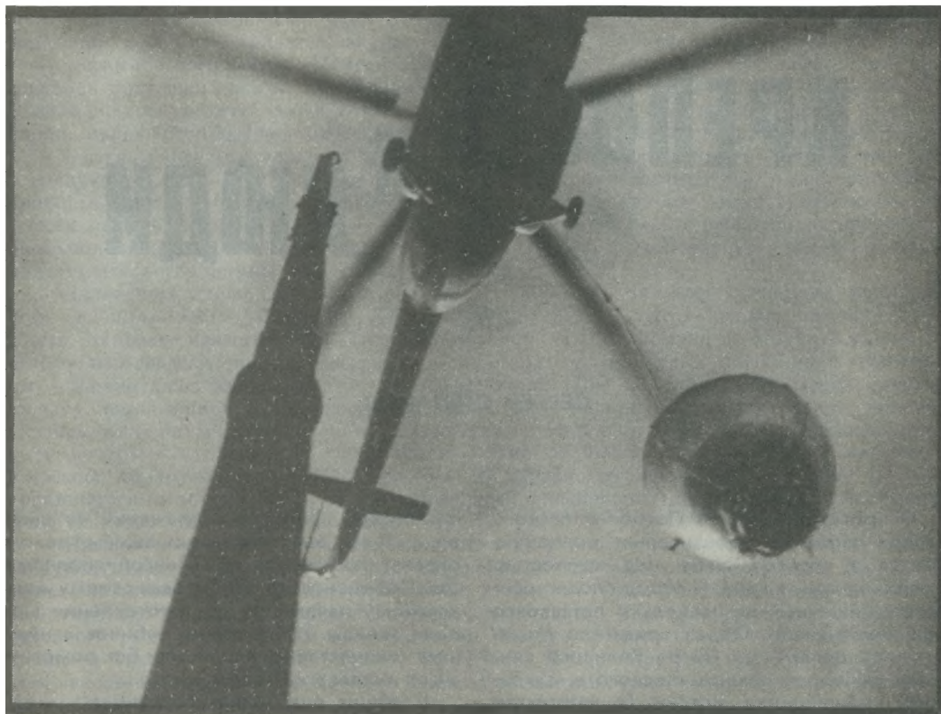
Демонтаж шара-«яблока» со шпиля Петропавловского собора. Июль 1992
