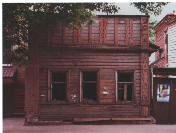
Остов здания на улице Минина, в котором летом 1971 г. временно проживал В. П. Серебряков. 4 августа 2006 г.
