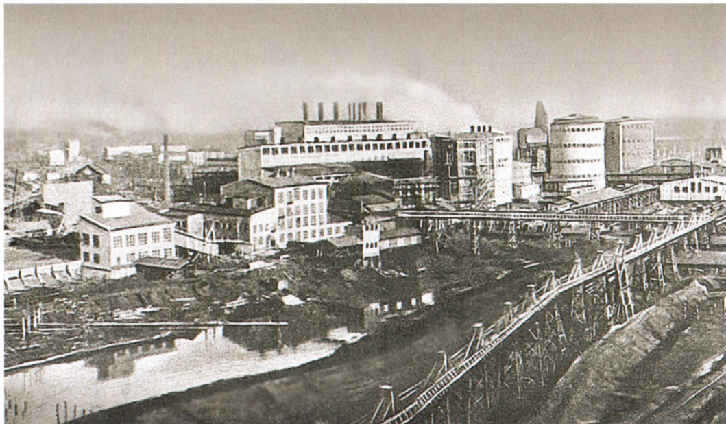
Первая очередь Березниковского химкомбината. 1932 г. ГОПАПО. Ф. 8043. Оп. 1. Д. В-254
