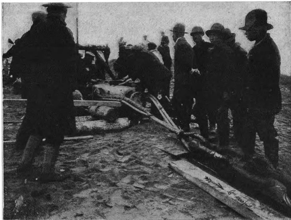
Прокладка подводного нефтепровода.
