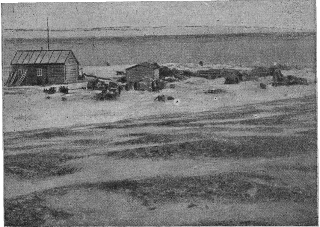
Северная Земля. Постройка станции
