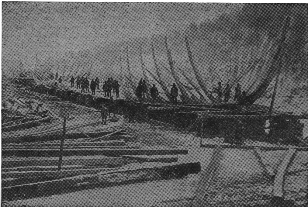
Придивненская верфь Комсервпути на Енисее. Постройка баржи
