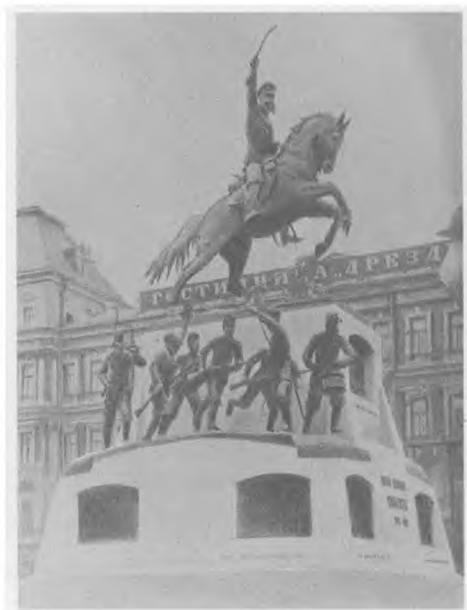
Москва. Памятник М. Д. Скобелеву по проекту П. А. Самонова на Тверской площади. Из собрания В. А. Дрибинского
