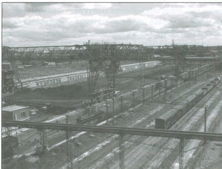
Современные виды Богословской ТЭЦ Цех топливоподачи
