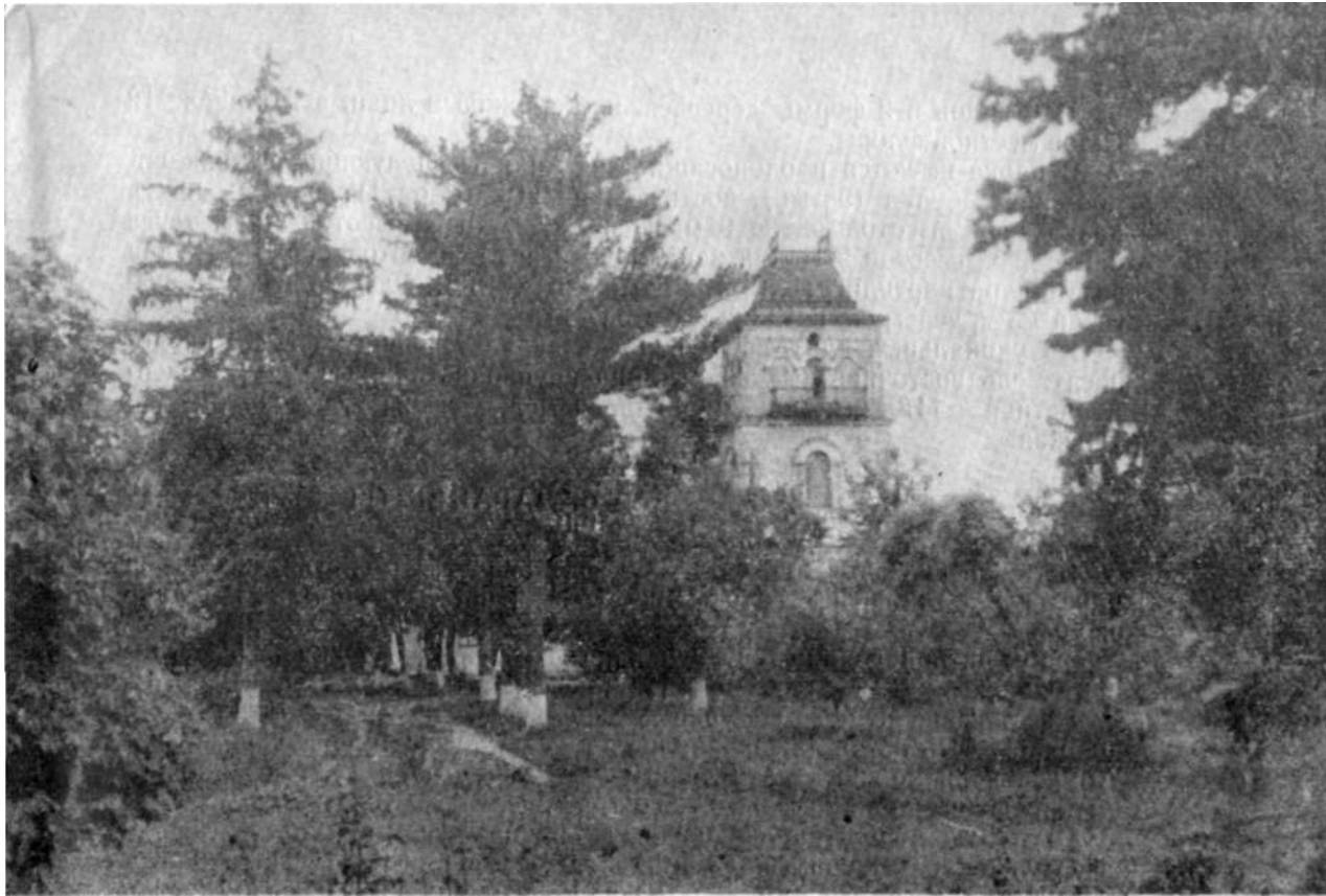
Рис. 44. Вид в сторону насосной станции
