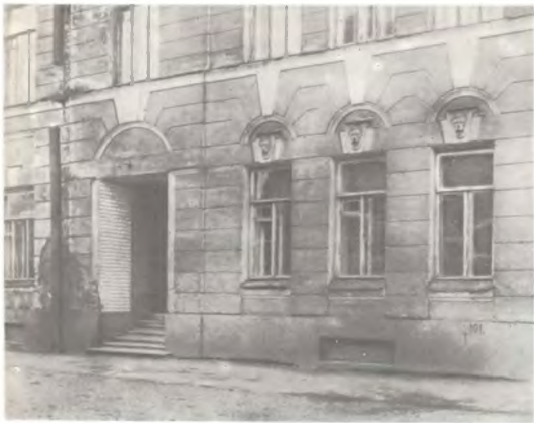
Подъезд дома на набережной реки Карповки.
