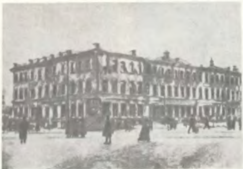
Восстановление разрушенного здания в Петербурге.
