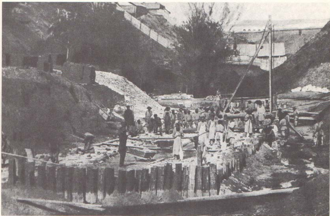
Строительство дамбы через овраг реки Симбирки. 1867 г. Фото А. Муренко. Частная коллекция.
