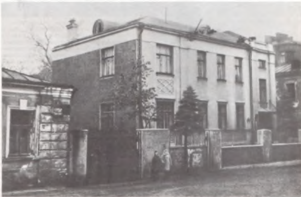
Дом в Дурновском пер., 1а, в котором Вернадские жили в 30—40-е годы (на втором этаже). Не сохранился.
